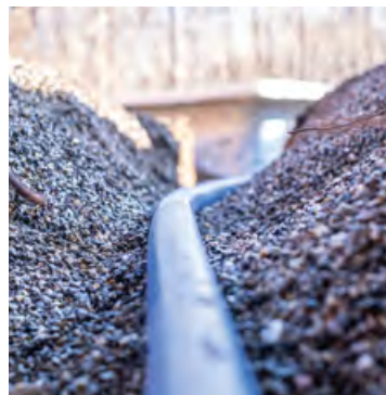
06. Installation des tuyaux
