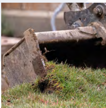
01. Excavation de la surface de la terre
