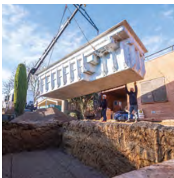
03. Pose de la piscine dans le trou
